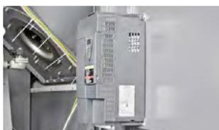
Die Filtertürme können mit Frequenzumrichter ausgestattet werden. Die Saugleistung kann so dem erforderlichen Bedarf angepasst werden, was zu zusätzlichen Energieeinsparungen führt.
