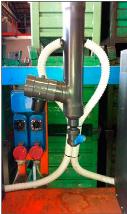
Calata a muro e raccordi alla batteria Wall descent and fitting to battery
